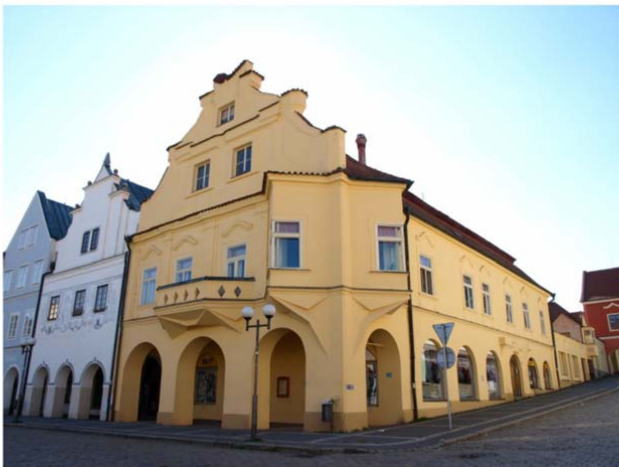
přestavba barokního domu v Pelhřimově
