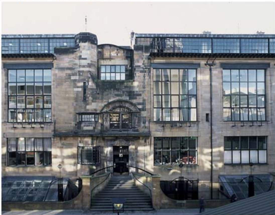
Vysoká škola uměleckoprůmyslová, Glasgow
