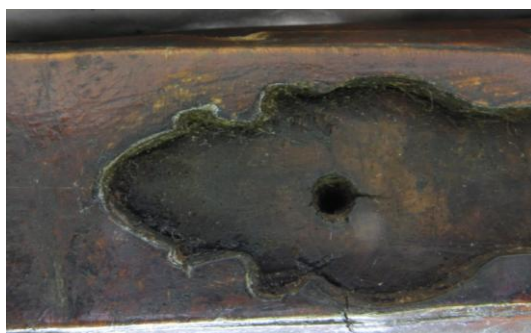
po očištění z povrchové úpravy dřeva
