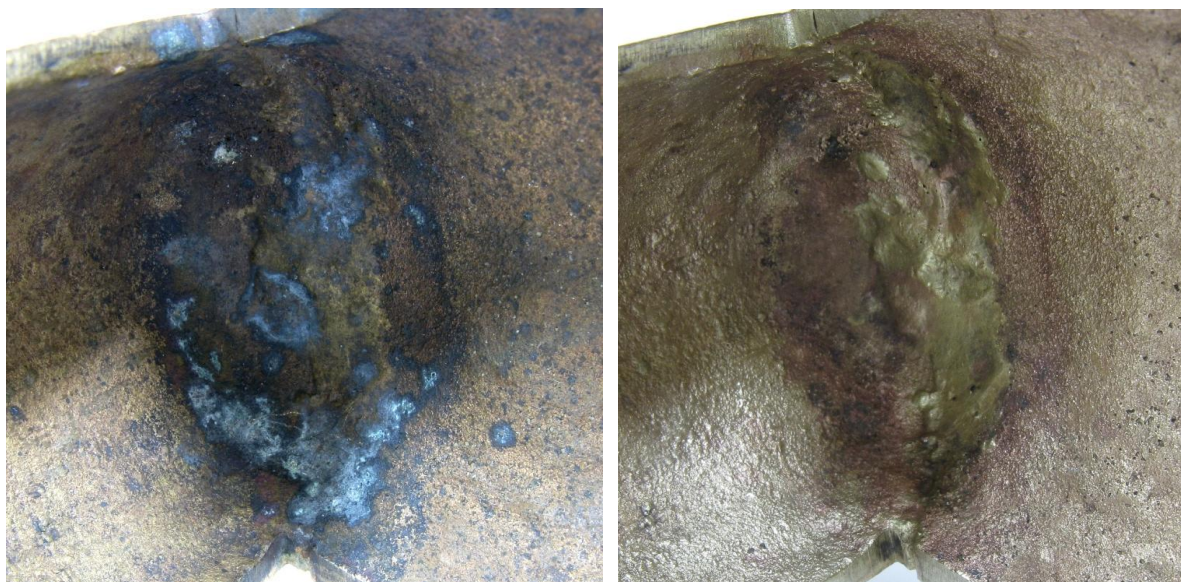
Obr.: odstraňování zelených korozních produktů
