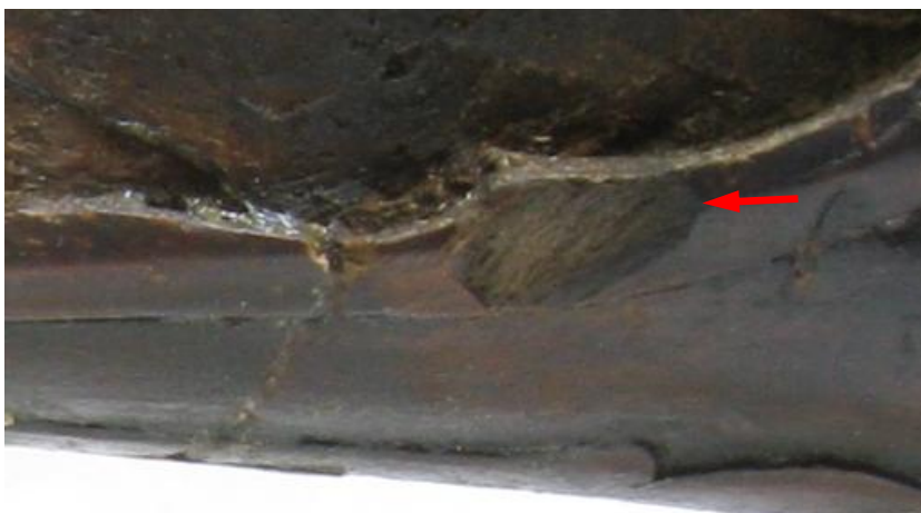
Obr.: Vyštípnutý okraj dřeva
