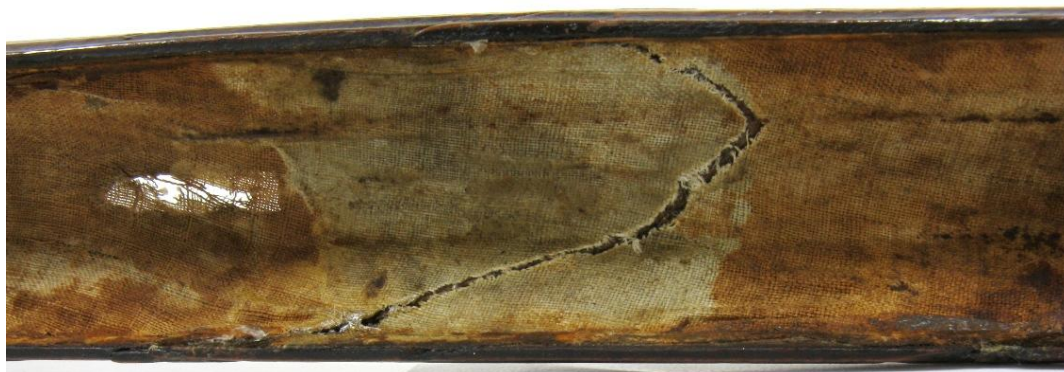
Obr.: Očištěná výztuž
