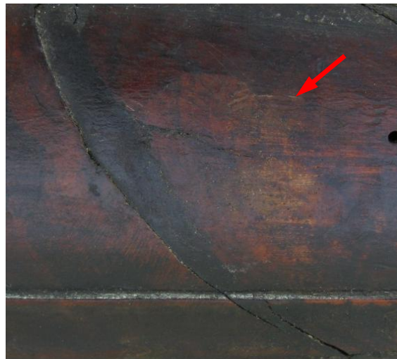
stav po odstranění druhotné opravy
