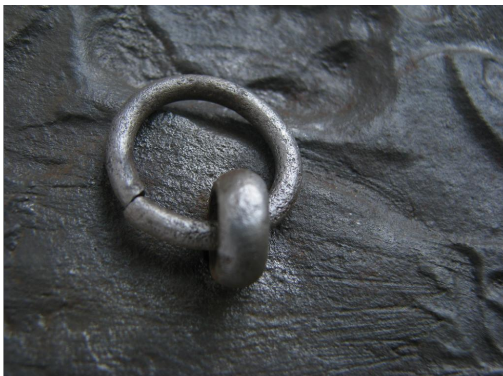
Obr. 20 Koroze byla odstraněna bez demontáže
