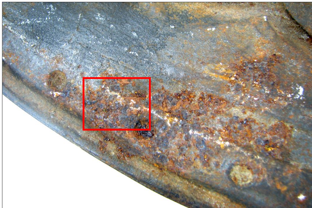
Obr. 11 Ukázka silného korozního napadení
