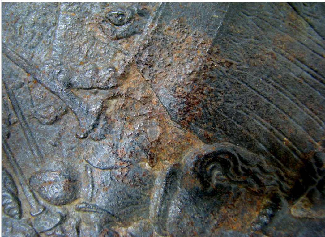
Obr. 9 Detailní pohled na lokální korozi – místy se objevují koroze ve vlhkém prostředí a korozní proces probíhá rychleji
