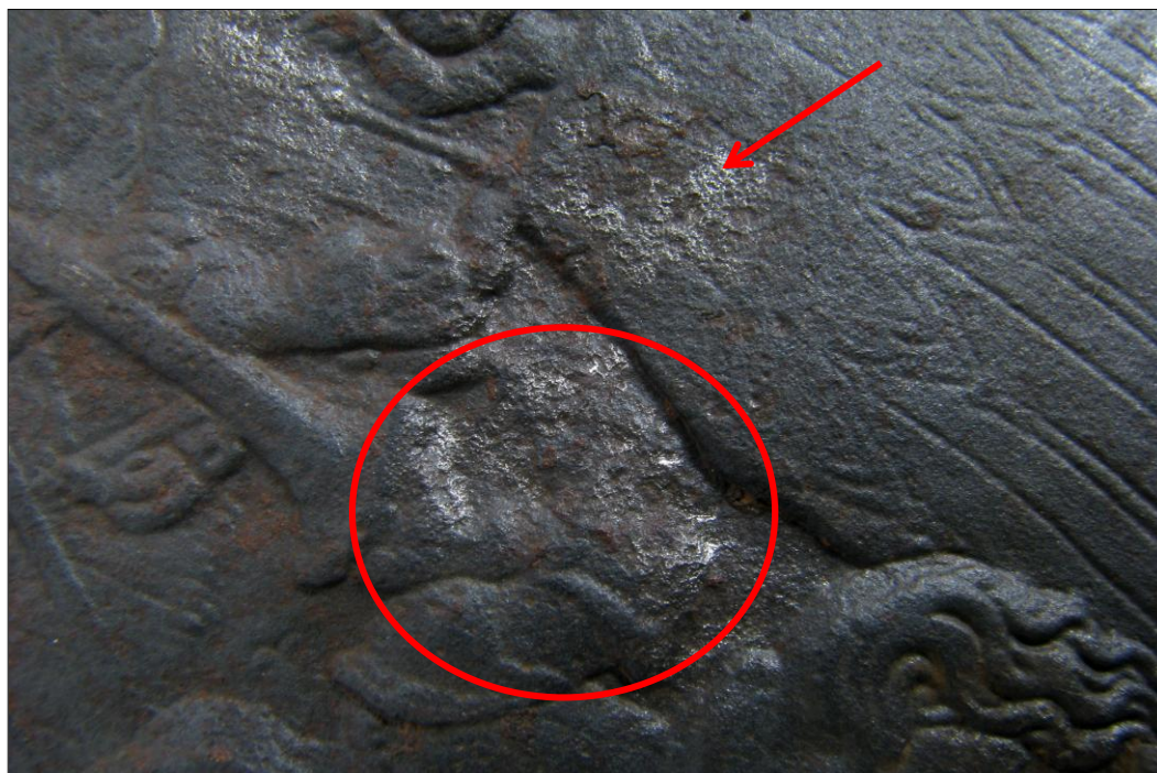
Obr. 17 Průběh otryskávání korozních produktů
