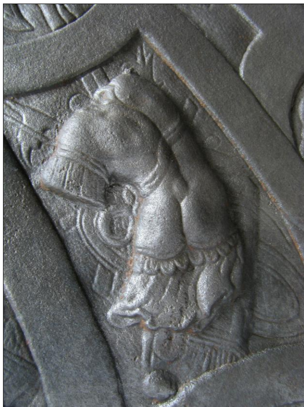
Obr. 18 úsek štítu během otryskávání
