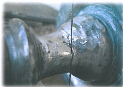
Obr. 50 Po teoretickém rozměření výplně, byla započata demontáž - lupenkovou pilkou
