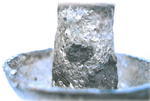
Obr. 71 Výztuž nožičky (lokálně narušená místa)
