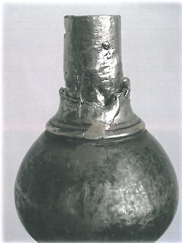
Obr. 99 Detail dříku s vloženou výztuží
